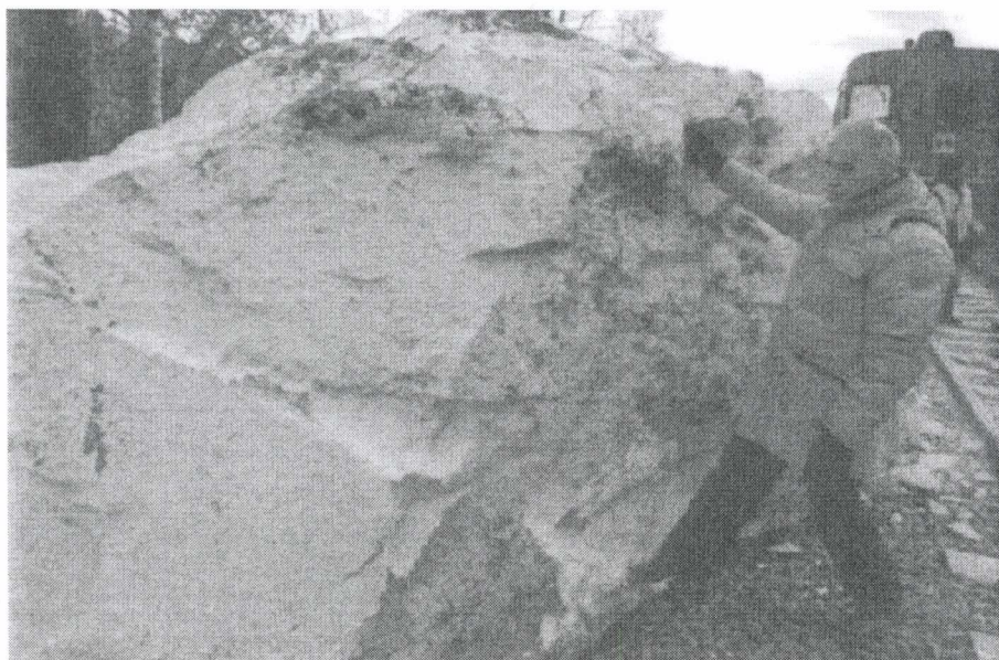
Foto 1 - L'elemento massiccio che ha causato l'incidente (fonte Relazione di Inchiesta di RFI - Allegati)
