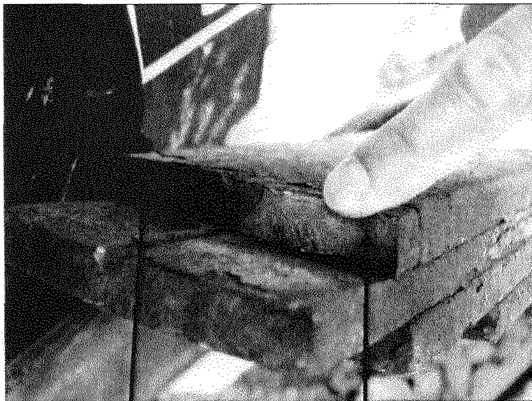
Figura 11- Dettaglio sezione balestra rotta
