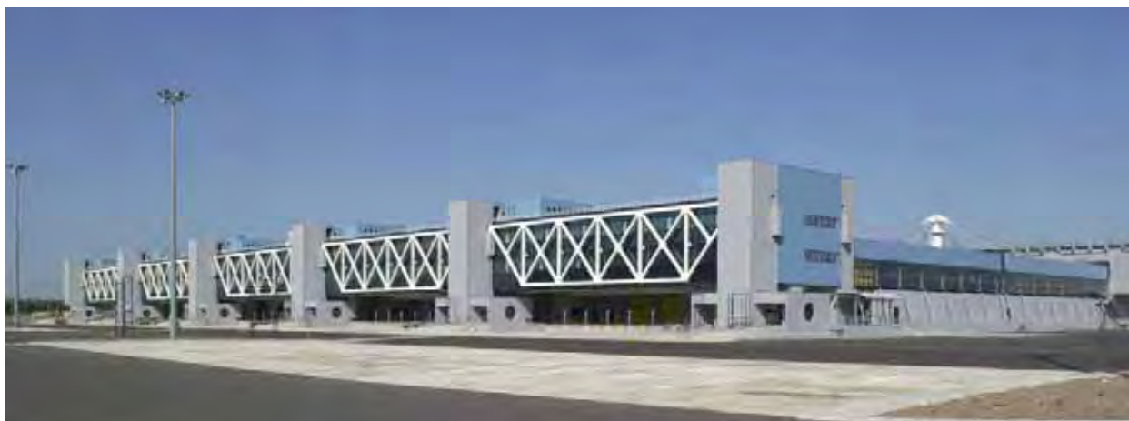
Figura 6– Cargo city – Edificio principale
