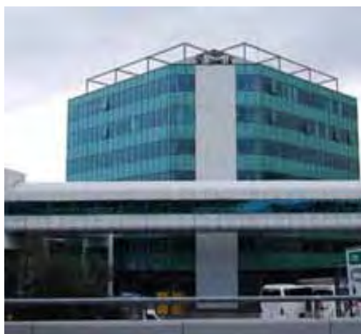
Figura 4– La torre uffici EPUA 2
