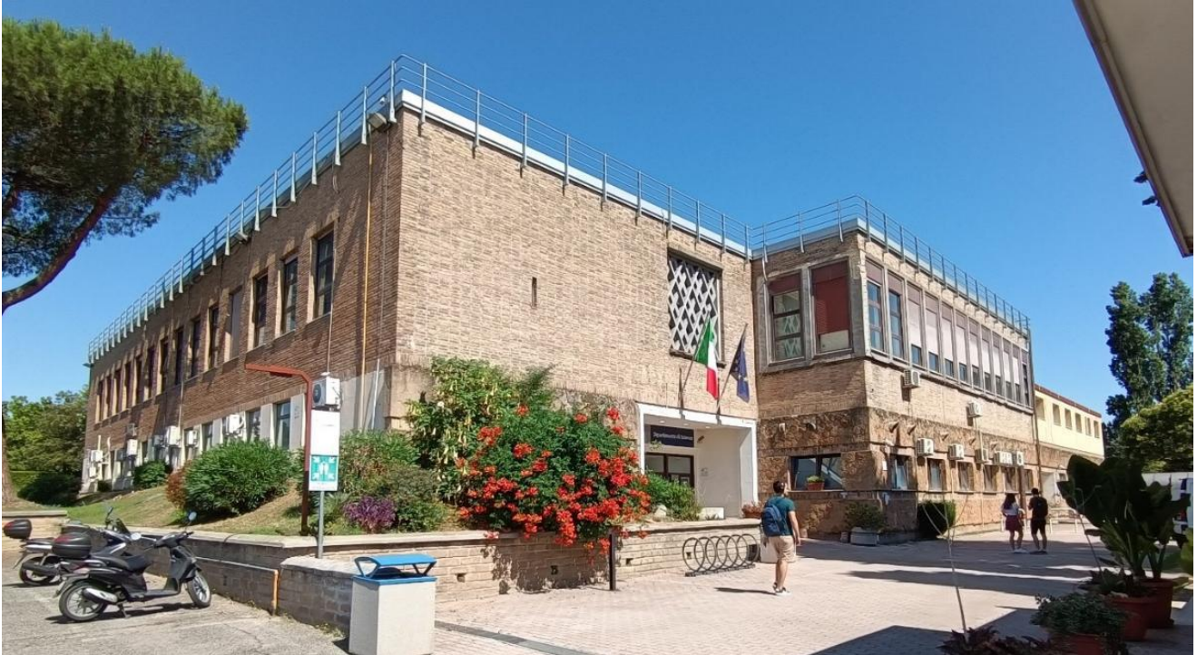
Vista esterna dell'edificio principale (Corpo A)
