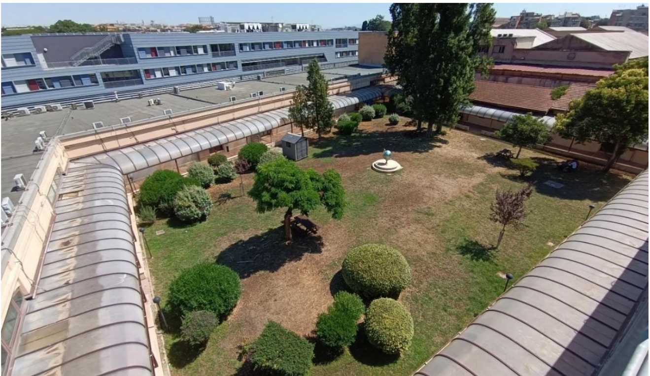
Vista dalla copertura dell'edificio principale, a sinistra il Corpo B, a destra il Corpo D
