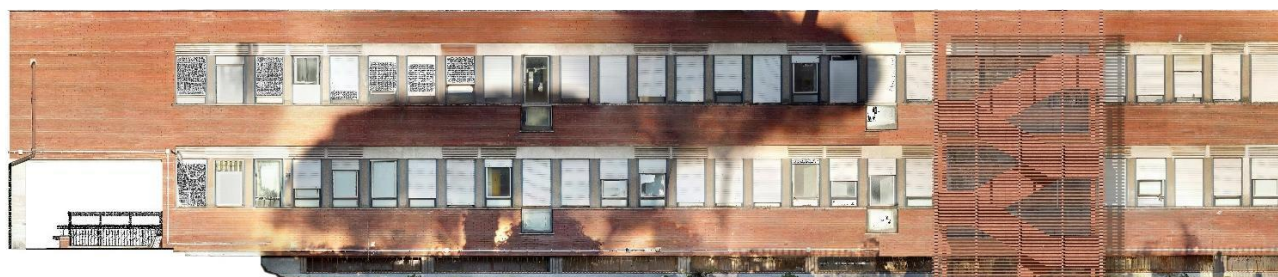
Stralcio del fotopiano su prospetto Sud-Ovest (POST-INTERVENTO)
