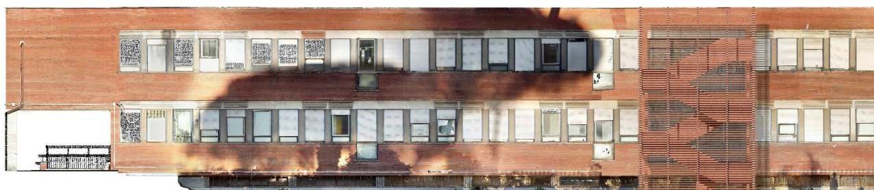
Stralcio del fotopiano su prospetto Sud-Ovest (POST-INTERVENTO)
