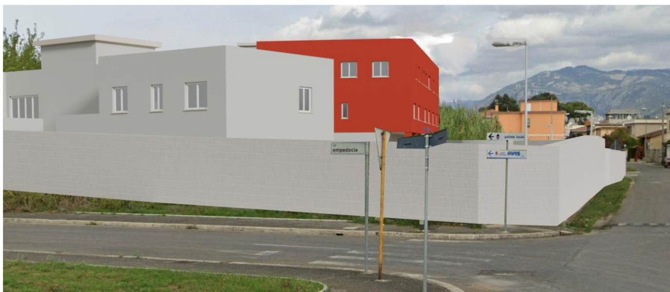
Vista D: esterno, spigolo sud
