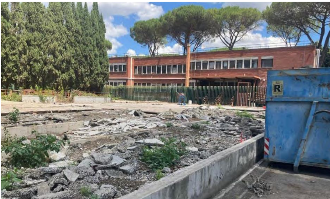
Foto interno lotto – basamento container
