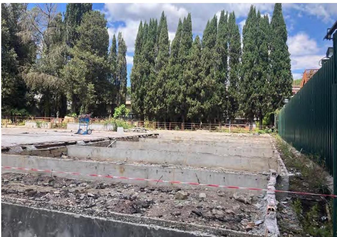
Foto interno lotto – basamento container in prossimità della recinzione Corpo 3
