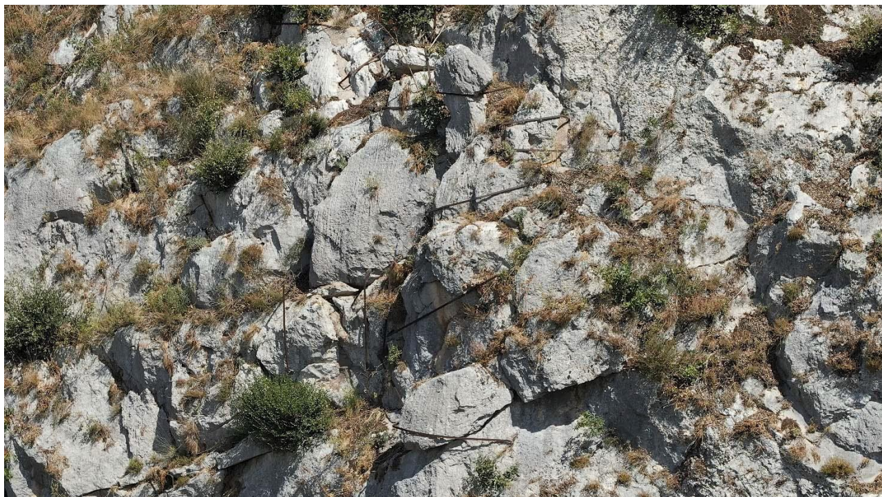
Stabilizzazione puntuale di blocchi con fasciatura
