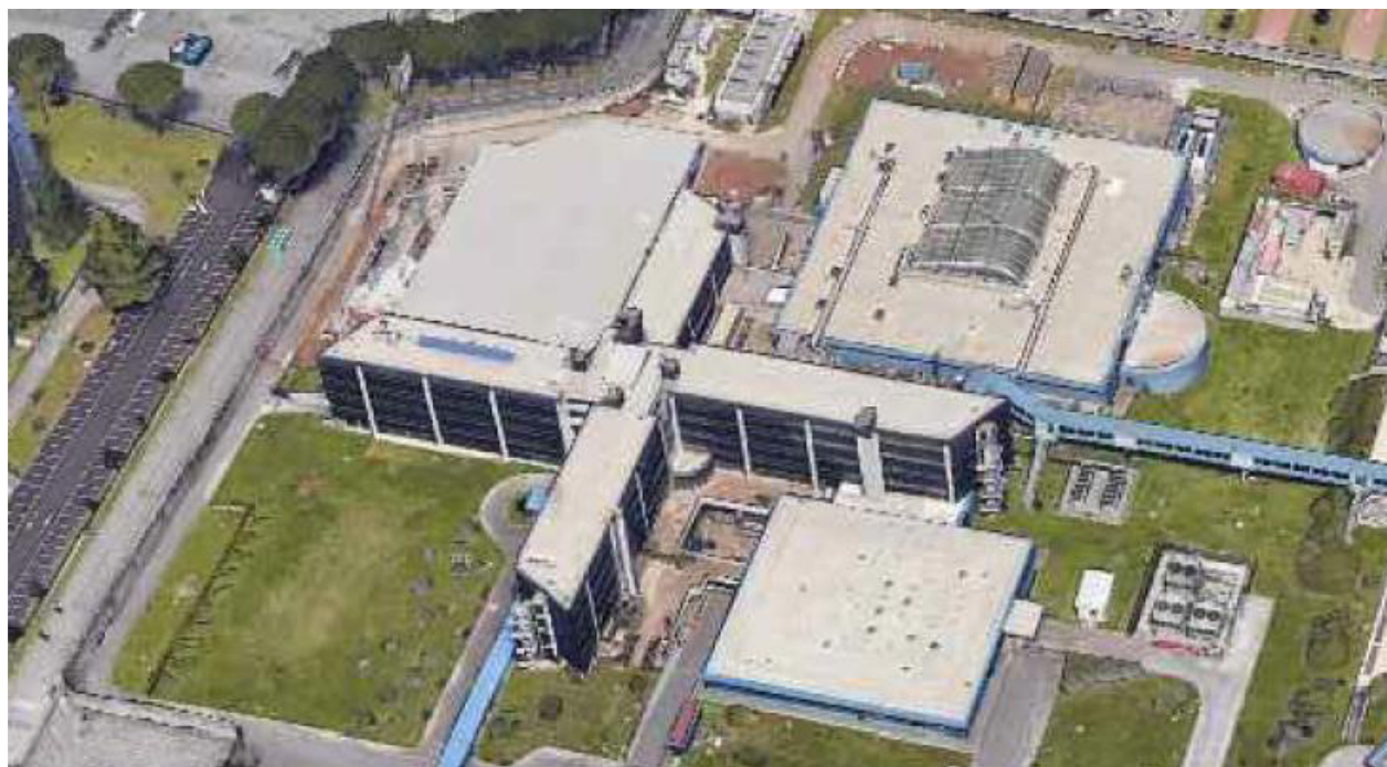
Vista aerea dello stato attuale, con l'intervento L1-L6 realizzato sulla base del Progetto esecutivo 2020
