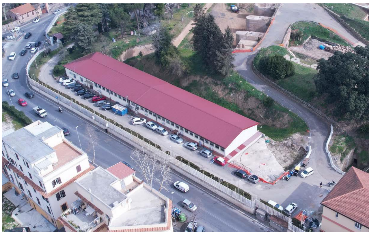
Vista dell'area prima degli interventi di demolizione
