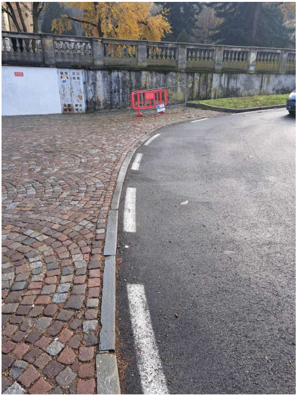
Pavimentazione in porfido da manomettere
