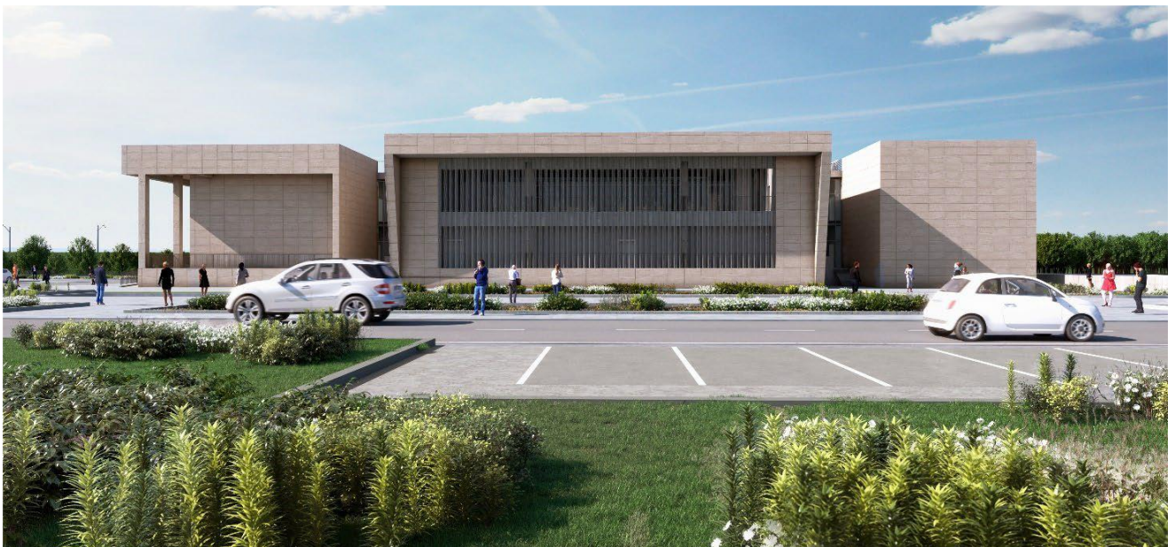
Vista del prospetto sud da via Pianopoli
