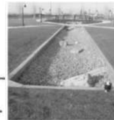
Tipologico di trincea d'infiltrazione
