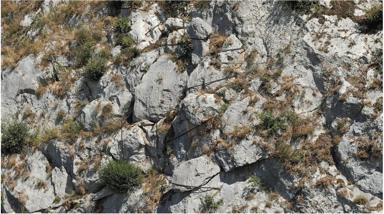
Stabilizzazione puntuale di blocchi con fasciatura
