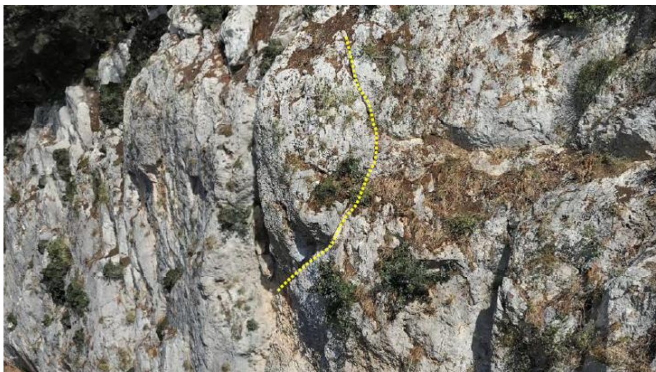
SITUAZIONE 1 – SCIVOLAMENTO PLANARE SU GIUNTO DI BASE
