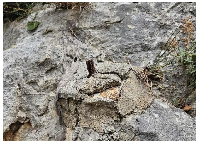
Chiodatura presente in sito e, a destra, sigillatura di fessure con malta cementizia
