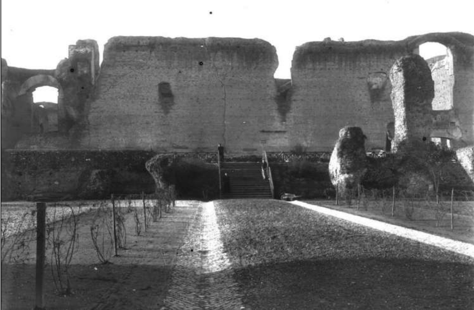
Inizio 900, vista scala da nord-est da V.le Terme di Caracalla
