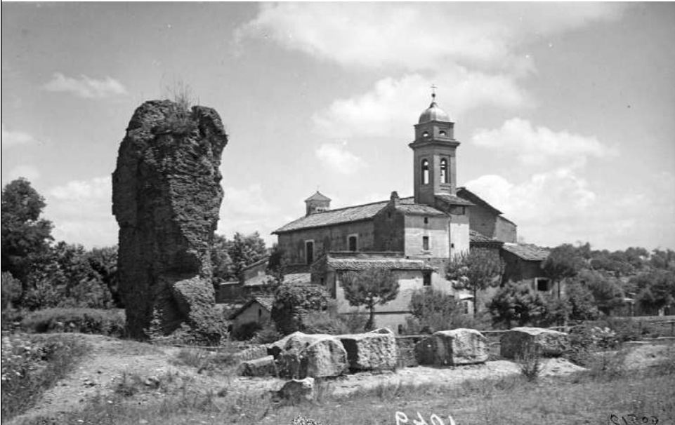
Inizio 900, vista da terrapieno verso Basilica di San Sisto Vecchio
