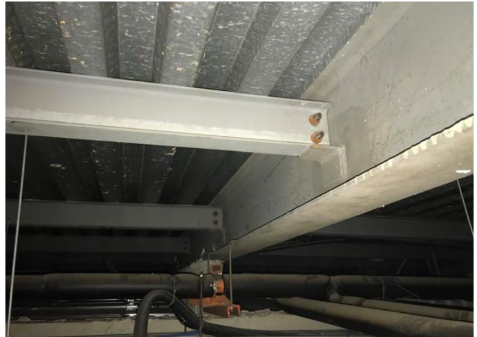
Sezione e vista dal basso del solaio di copertura, con la lamiera grecata, le travi secondarie IPE100 e principali IPE270
