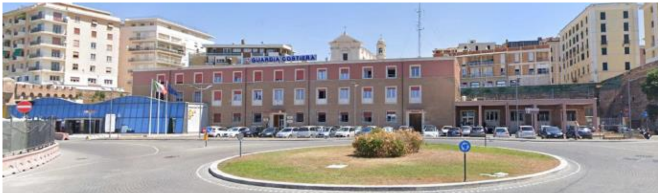
Vista attuale del complesso
