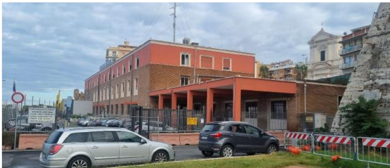
Vista attuale del complesso
