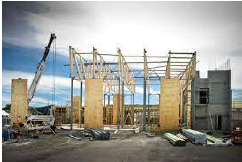
Figura 82. Esempio di travi reticolari del centro congressi Carterton Event Centre (Nuova Zelanda)
