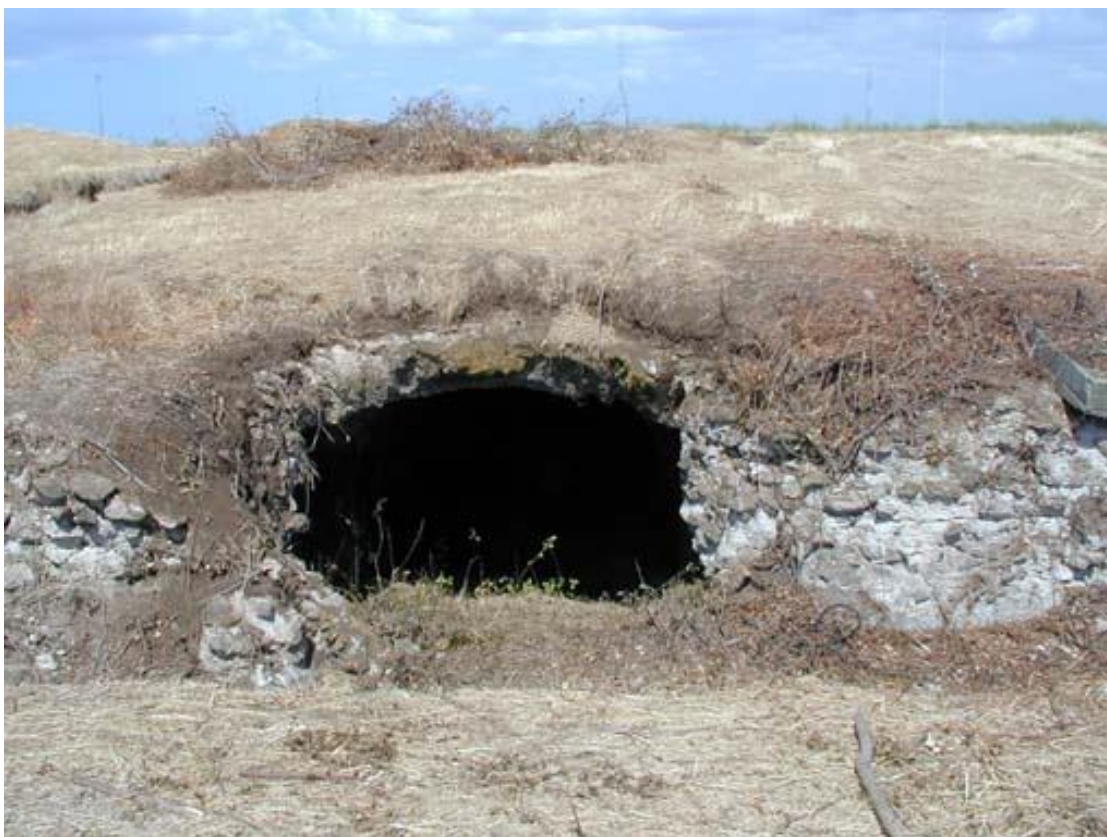
Accesso alla cisterna
