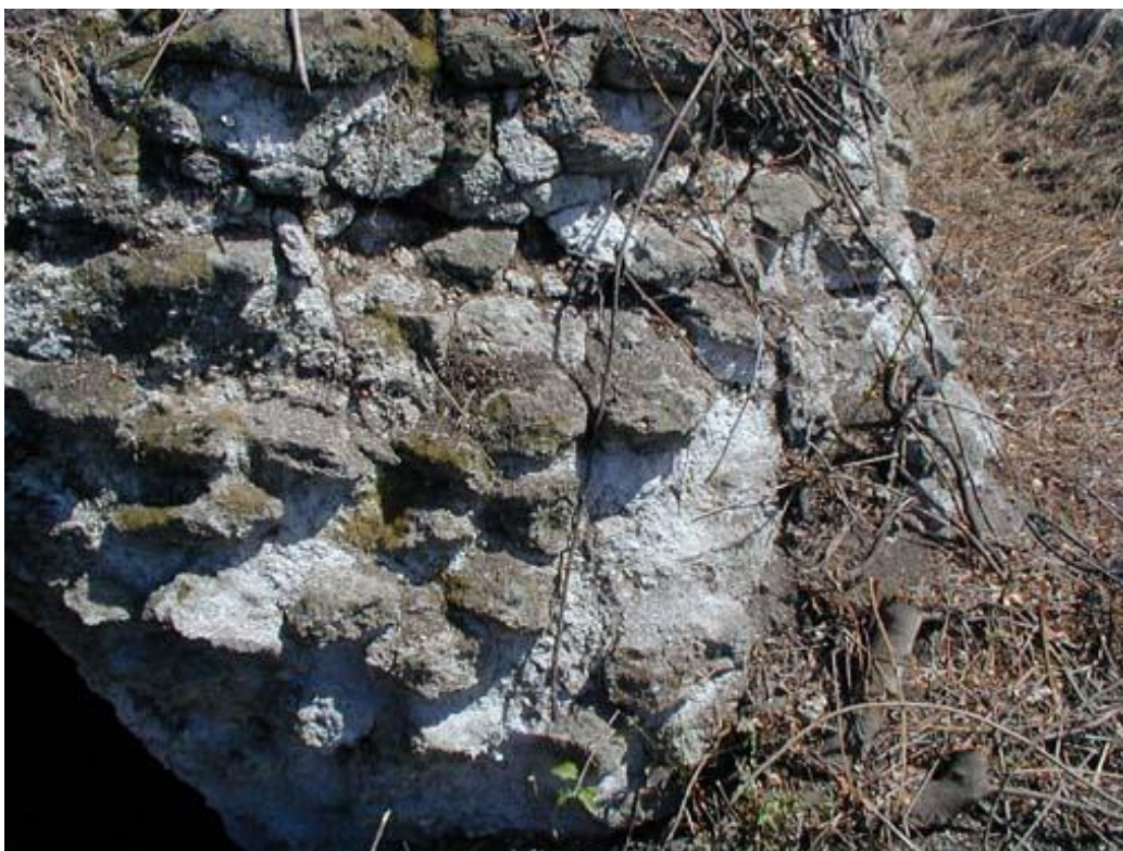
Particolare del muro perimetrale
