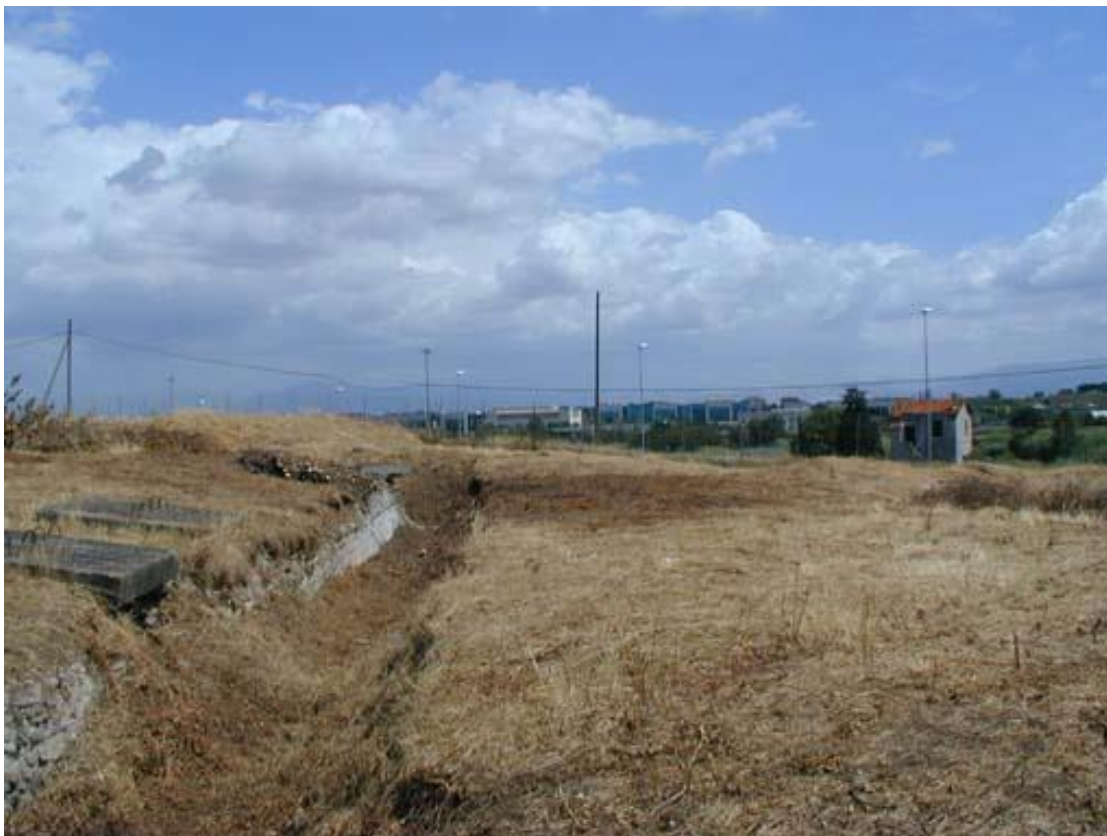
Terreno sovrastante la copertura, trincea del lato ovest, lastre in cemento armato.
