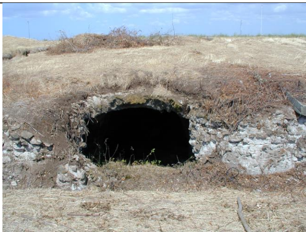
Fig. 3 - Accesso alla cisterna
