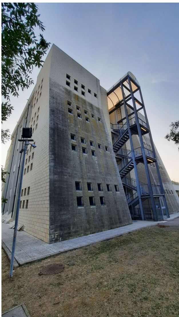
FOTO 1: parete a fronte della quale sarà collocata la vasca antincendio
