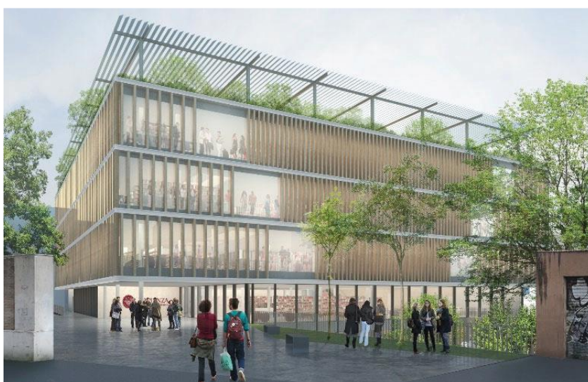
Vista nuovo ingresso via dei Marrucini
