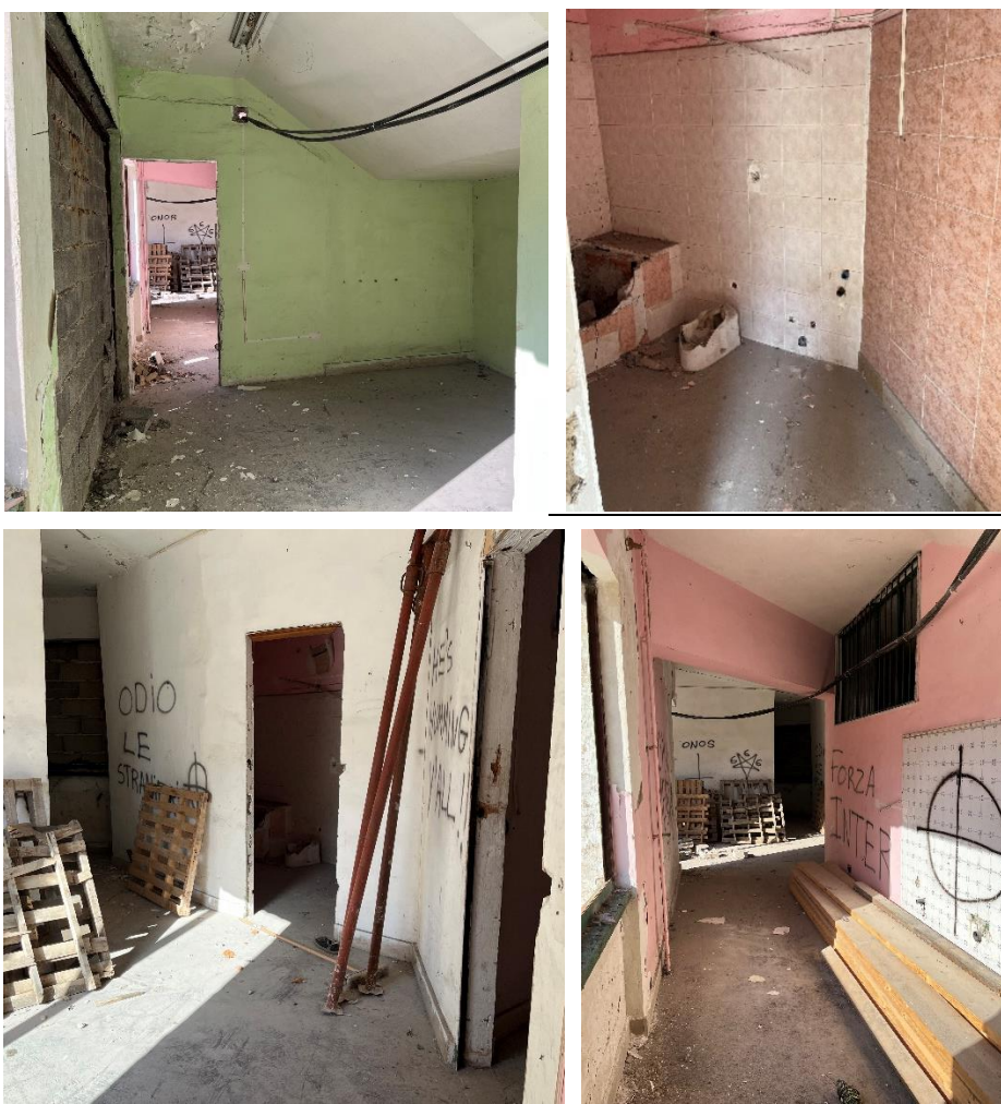
Figura 10 - Viste interne degli ambienti di servizio e servizi igienici
