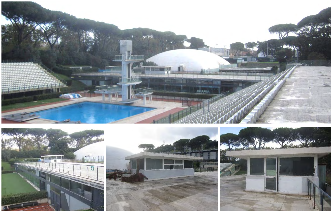
Immagini di riferimento del manufatto da demolire presente sulla terrazza dell'ex ristorante
