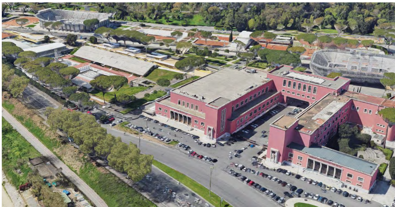
Figura 51 – La piscina coperta (ing. Costantino Costantini)
