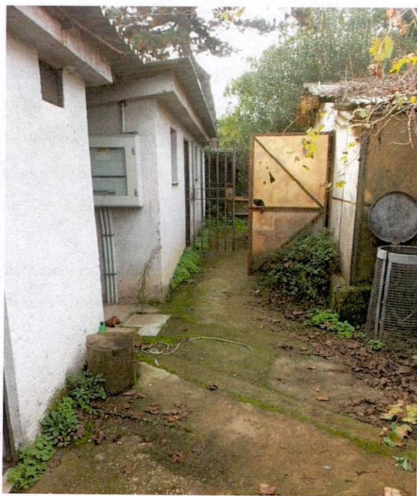
7. Viste degli edifici da demolire
