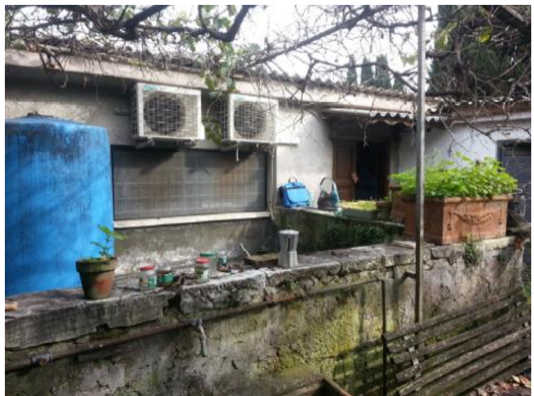
Viste degli edifici da demolire
