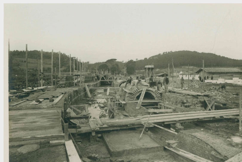
FOTO STORICHE - CANTIERE
