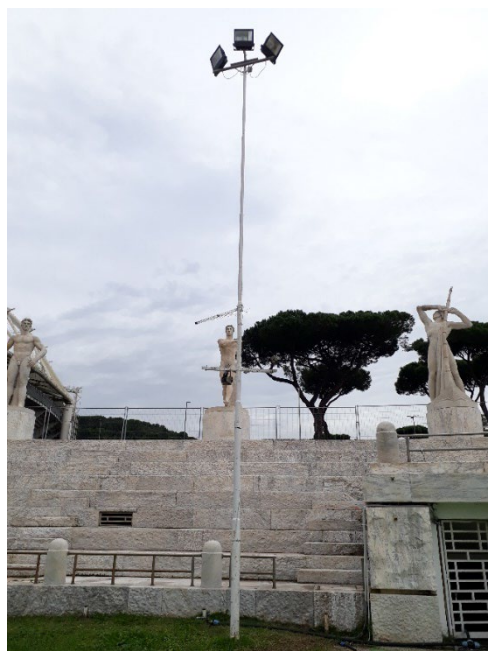
PALO METALLICO PRESSO LATO NORD
