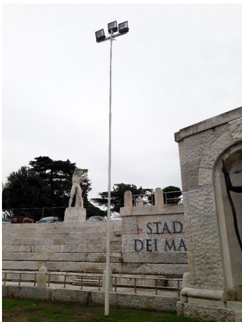
PALO METALLICO PRESSO LATO SUD
