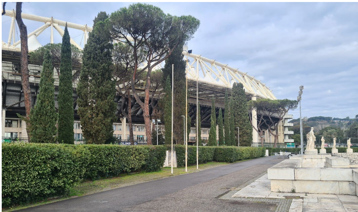
Foto della risagomatura della siepe in corrispondenza del cancello di collegamento con lo Stadio Olimpico
