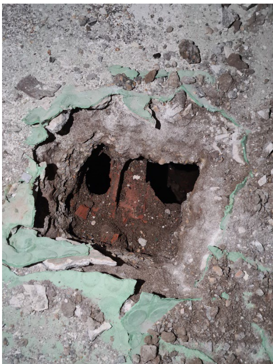
Tavelloni del solaio
