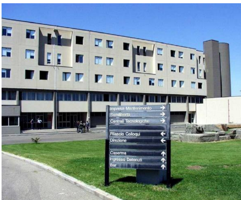
Edificio Omnibus con Caserma agenti e Direzione
