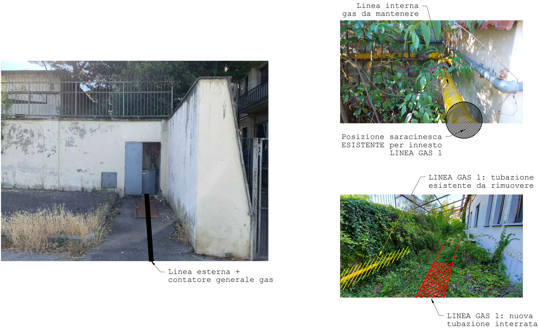
Documentazione fotografica contatore generale GAS
