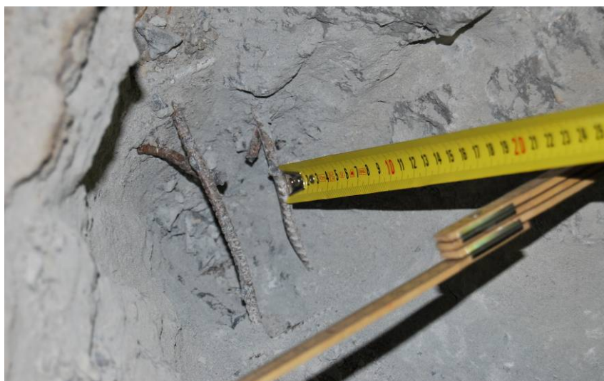
Figura 7. Dettagli d'armatura della platea di base (saggio n.1).
