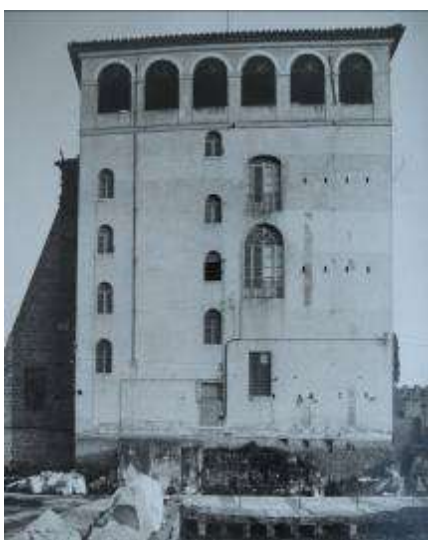
Museo Palatino, corpo scala con altana prima della demolizione
