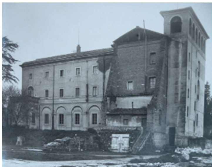
Museo Palatino, aprile 1936 - Visibile ancora il terzo piano demolito
