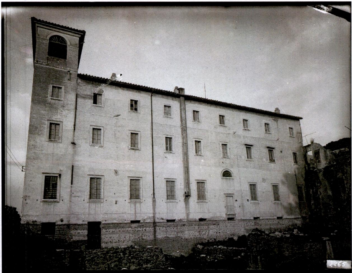
2. Antiquario Palatino, prospetto posteriore prima dei lavori del 1938
