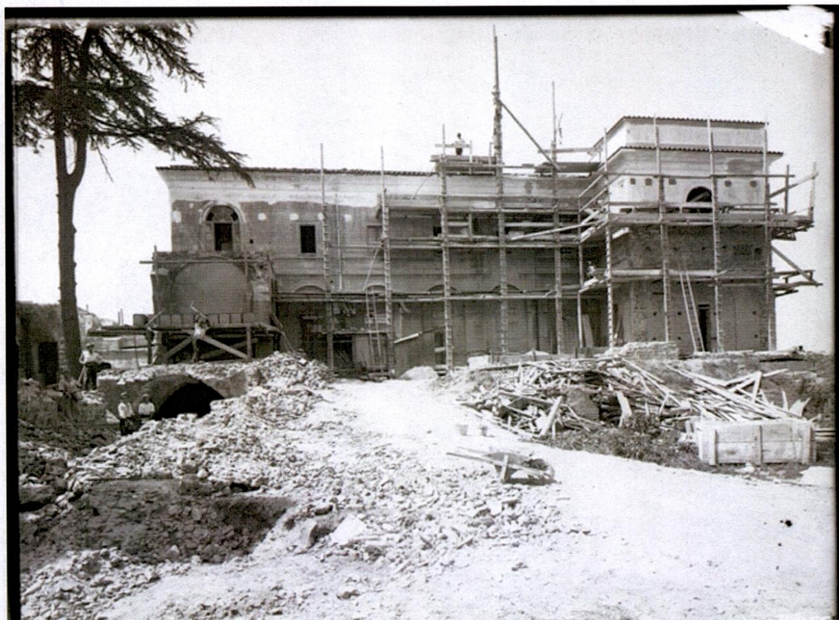
4. Il cantiere di ristrutturazione realizzato da Bartoli in corso
