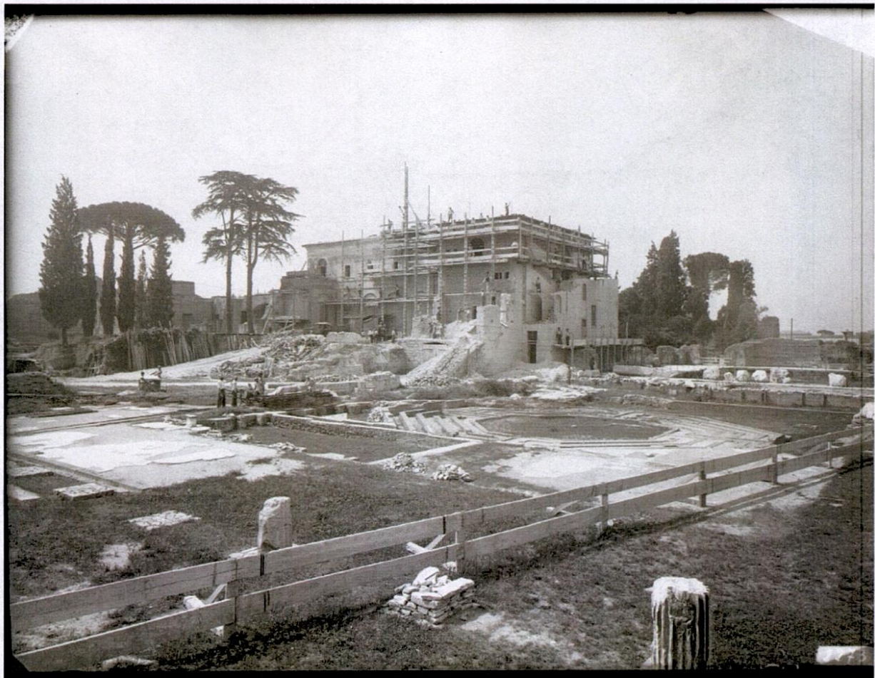
5. La demolizione dell'ultimo piano appena effettuata
