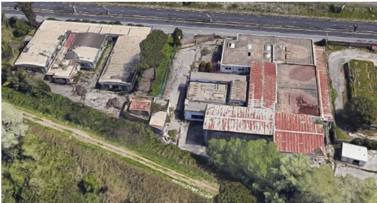
Vista aerea dei fabbricati da ovest
