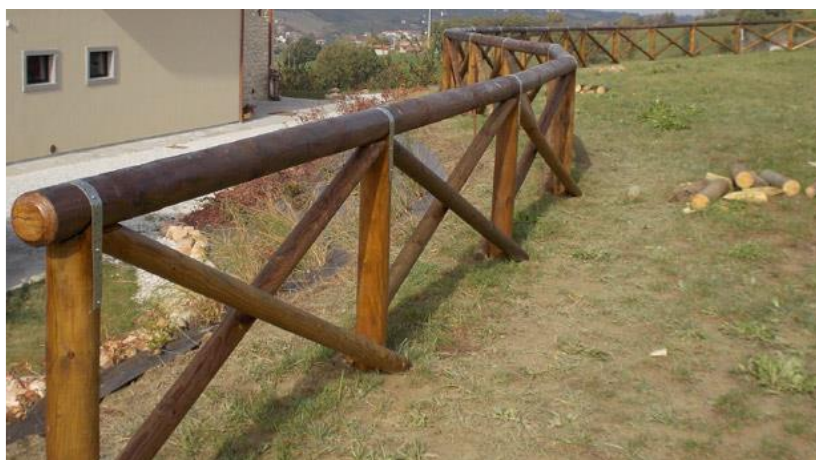
Esempio fotografico della staccionata
