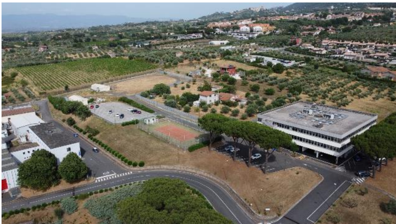
Figura 22: Vista aerea dell'area di intervento dalla zona ovest.
