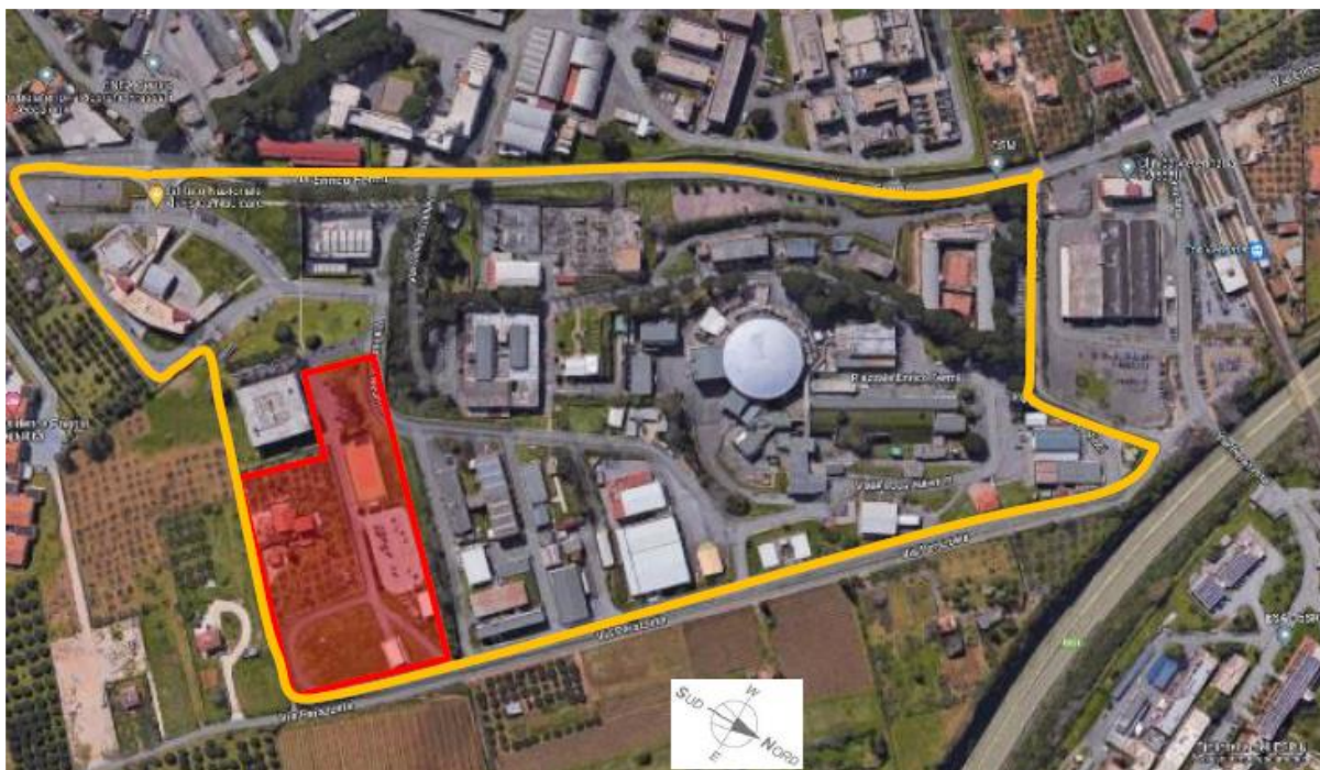
Figura 3: Vista aerea (fonte Google Maps) dei Laboratori Nazionali di Frascati con evidenziata in verde l'area oggetto di intervento.
