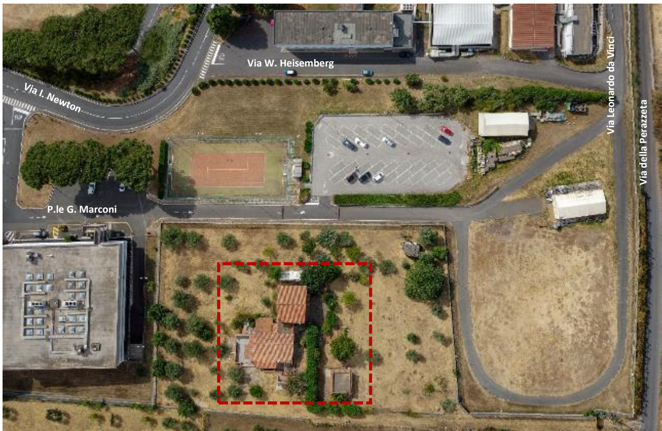
Figura 21: Ortofoto dell'area oggetto di intervento con evidenziati gli edifici demoliti nel luglio 2022.
