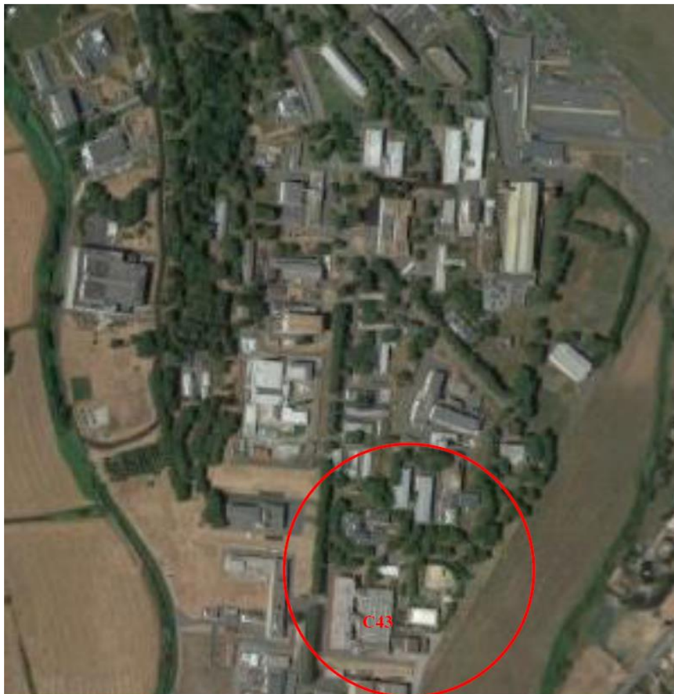
Figura 2 - Edificio C43 e sito di installazione container
