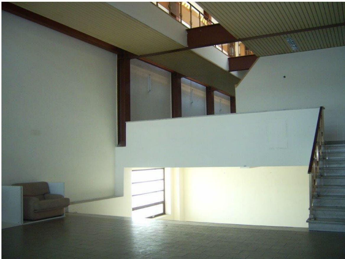
Ingresso della Biblioteca, trasformazioni anni '80: la nuova struttura metallica con la passerella degli uffici
