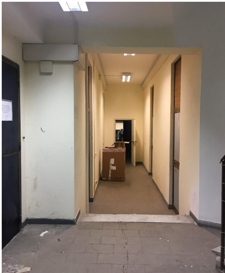
Stato attuale: vista del piano seminterrato con i tramezzi aggiunti e in stato di abbandono
