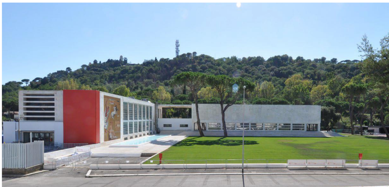
Stato attuale da viale delle Olimpiadi
