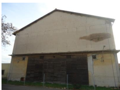
fig. 36 - Prospetto edificio, lato viale di accesso
