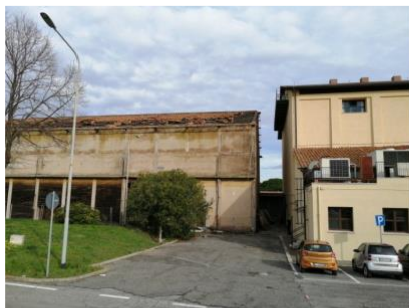
fig. 39 - Vista lato piazzale
