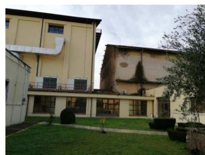
fig. 38 - Vista lato cortile interno
