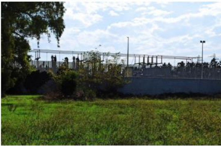
Particella 11: confine con Centrale elettrica ACEA
