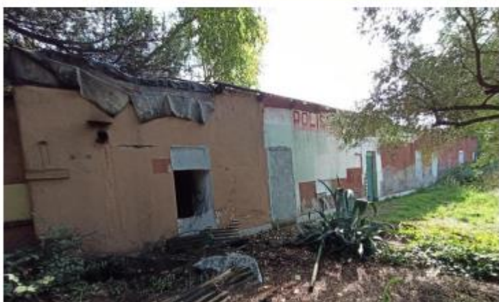
Particella 11: confine con Centrale elettrica ACEA
