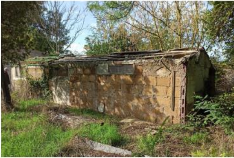
Particella 11: manufatti esistenti
