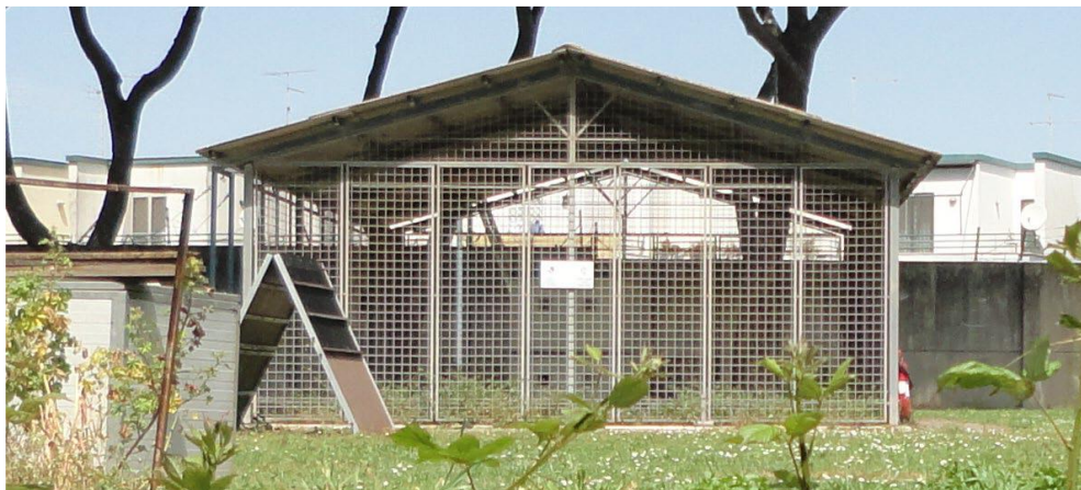
Immagine 10 – Deposito esplosivi
