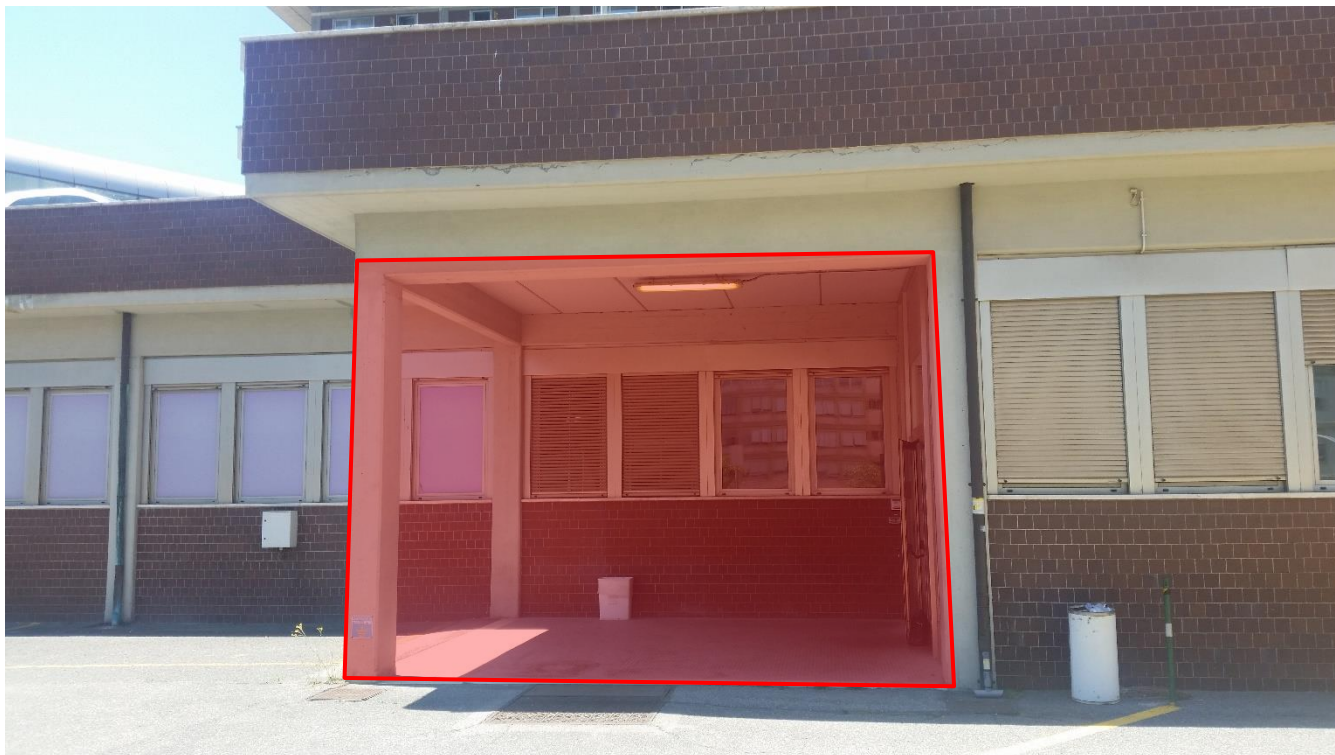
Vista del Prospetto Est in corrispondenza della tettoia che sarà chiusa
