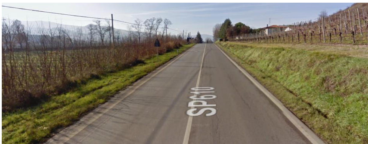
Figura 5 – Borgo Tassignano – Il rettifilo prima dell'intervento di sistemazione
