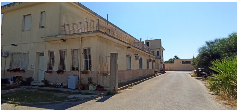
Vista dalla postazione di rilievo
