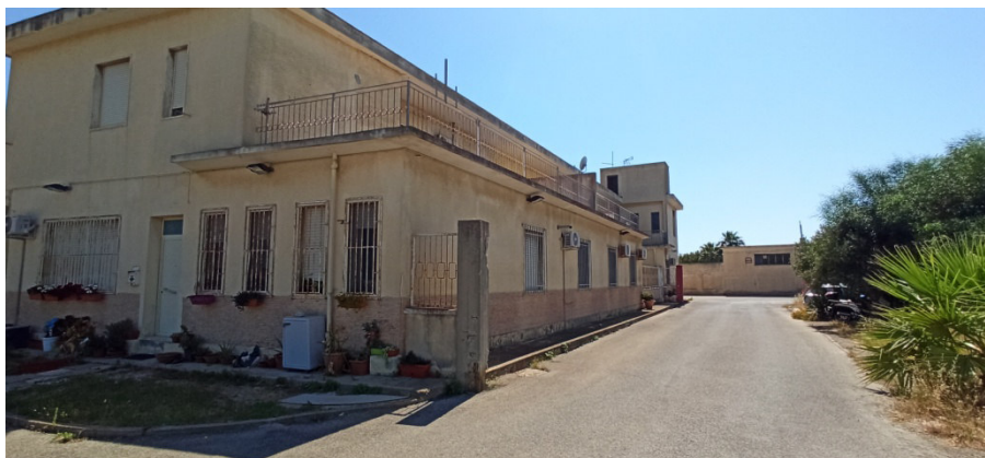
Vista dalla postazione di rilievo
