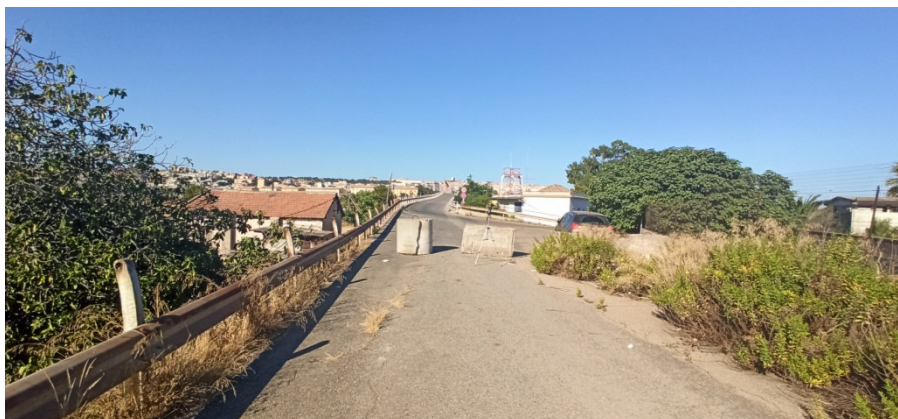
Vista dalla postazione di rilievo
