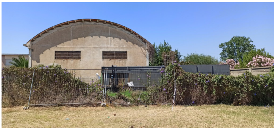
Vista dalla postazione di rilievo
