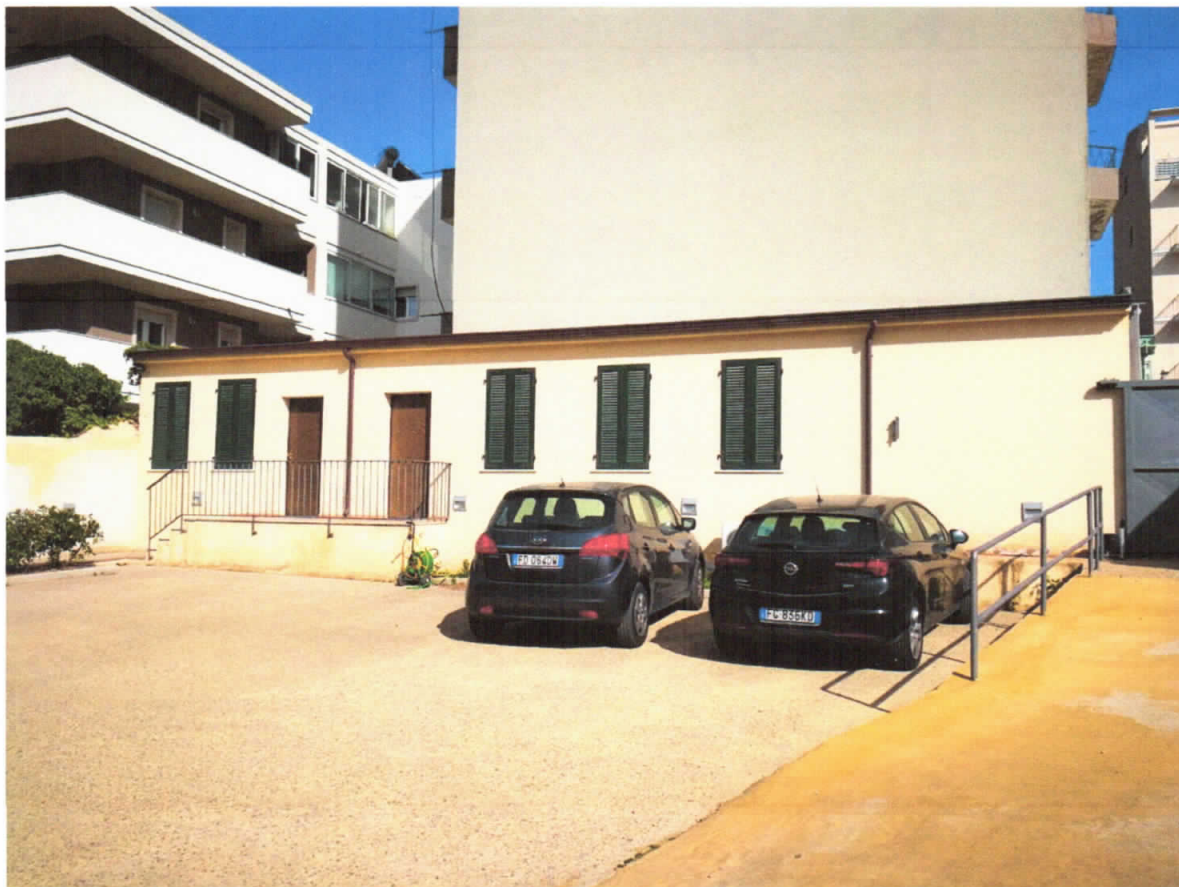
Fig. 3 – Il fabbricato oggetto della ristrutturazione nel lato Via Principe di Piemonte.
